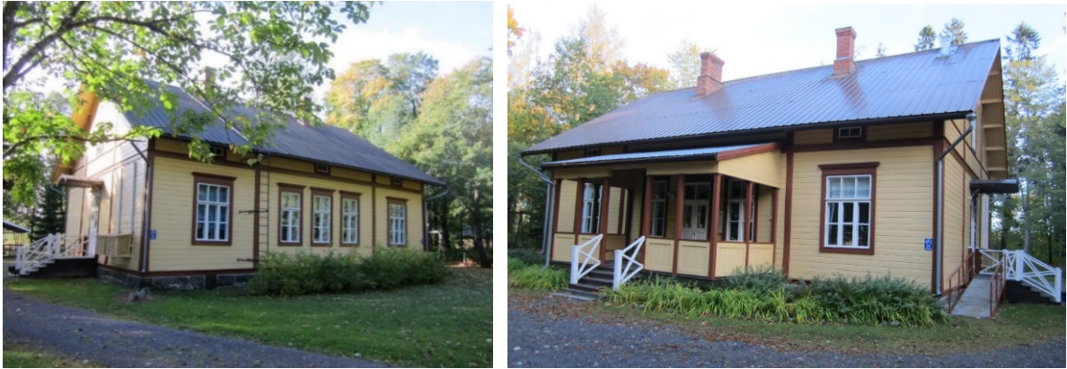
Kuva 4. Kapteenintalon julkisivu koilliseen ja lounaaseen, kuvattu 9/2018
