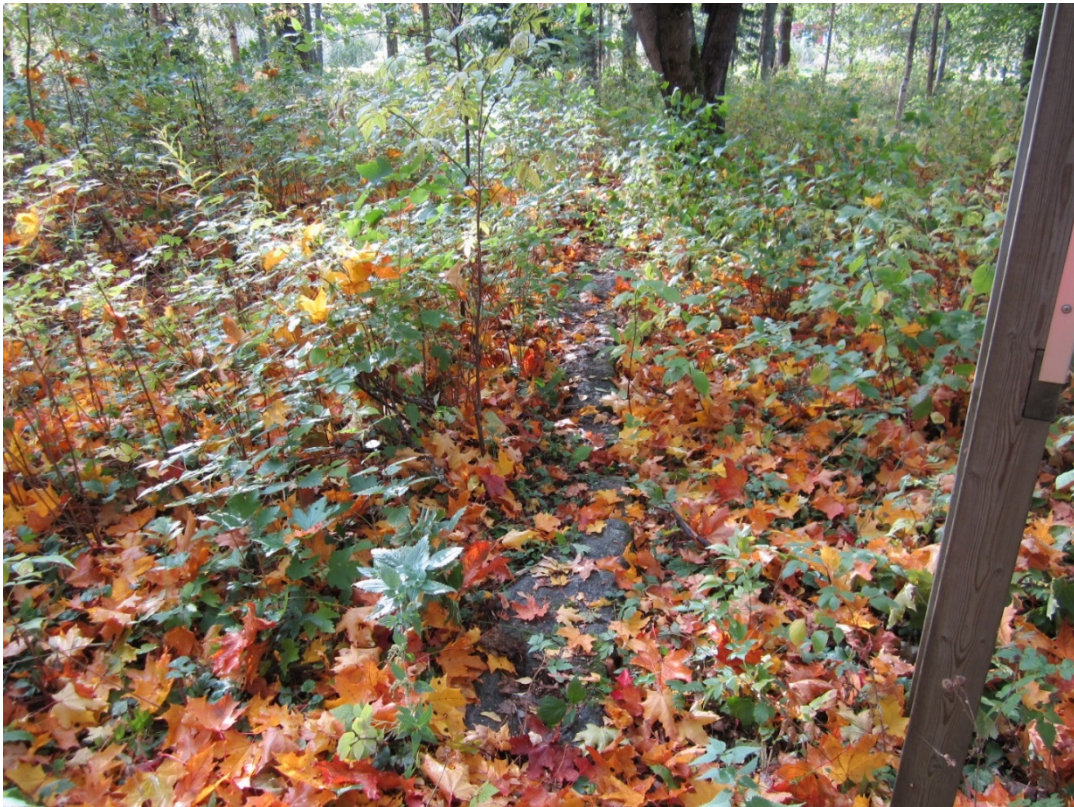
Kuva 5. Kivijalkaa luoteissivulta, kuvattu 9/2018
